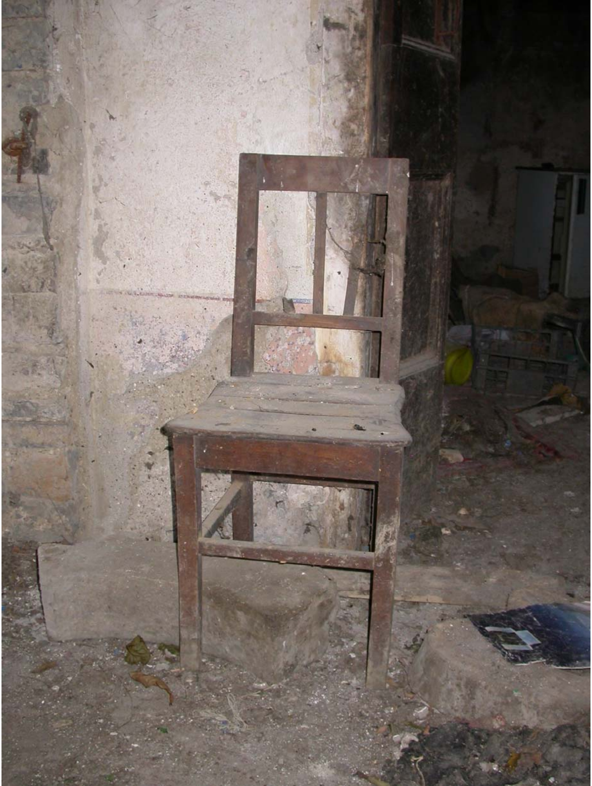
L'intérieur n'est plus que poussière, chénit, meubles à l'abandon.
